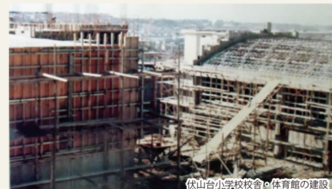
伏山台小学校校舎・体育館の建設
